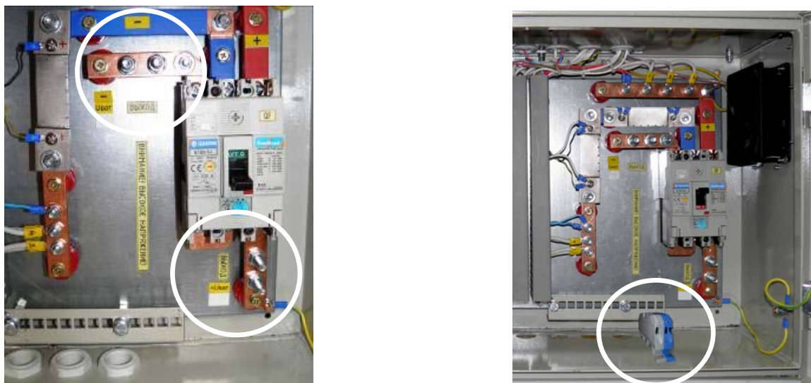
Рис.5. Зона присоединений кабелей/проводов нагрузок.
