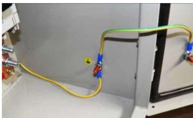
Рис.3. Болт подключения внешнего заземления.
