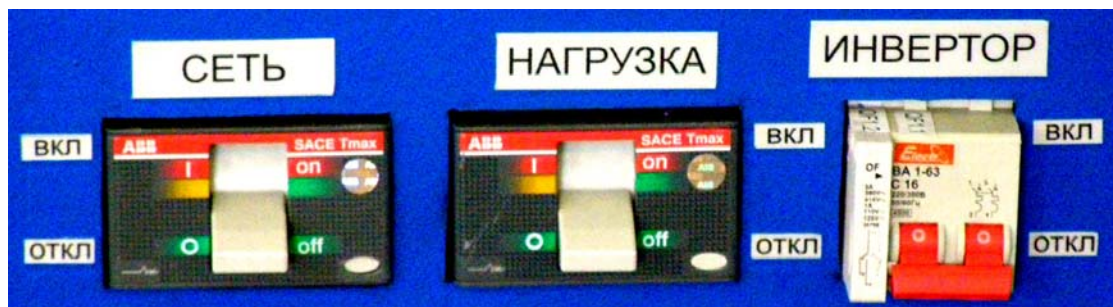
Рис. 4 Расположение автоматических выключателей на панели управления
