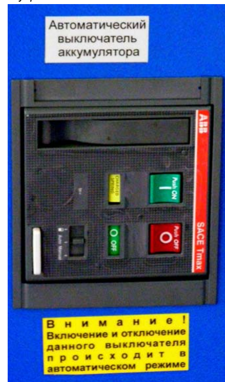
Рис. 4 Расположение автоматических выключателей на панели управления
