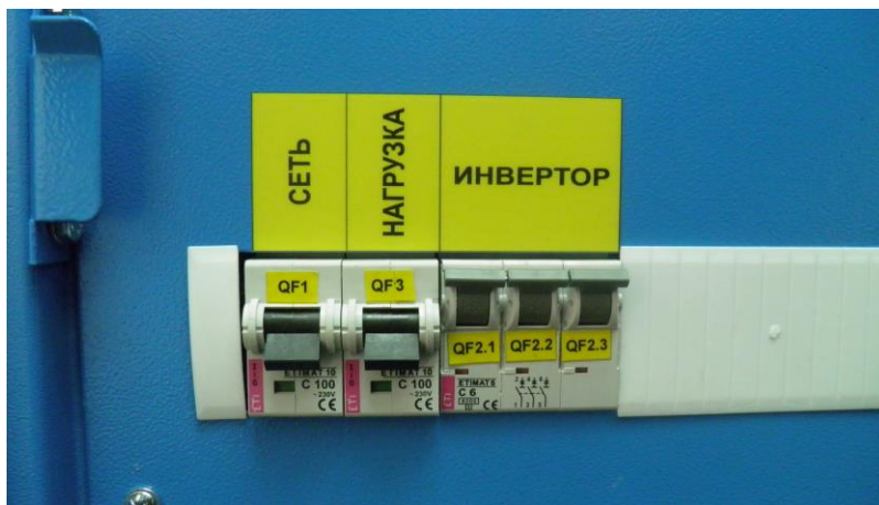
Рис. 4 Расположение автоматических выключателей на панели управления
