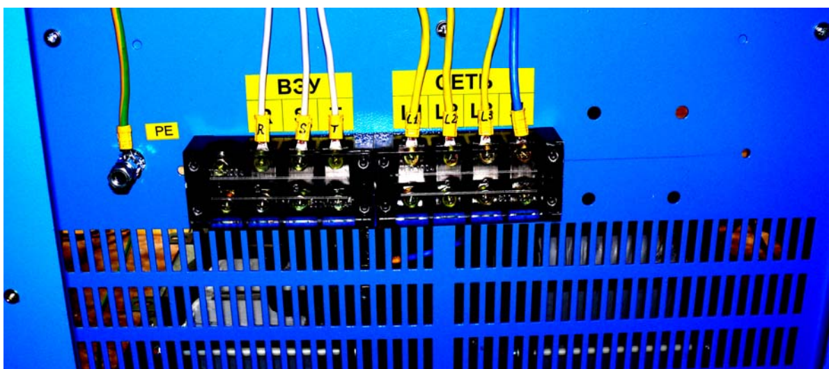
Рис. 3 Расположение клемм в клеммном отсеке инвертора
