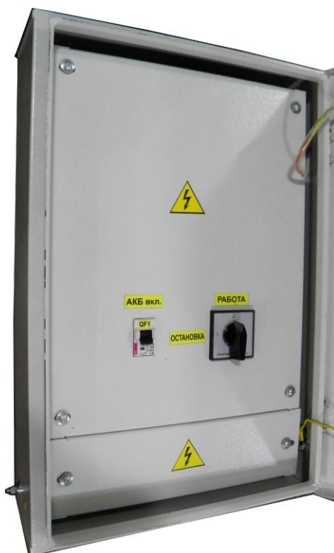
Рис. 1 Расположение органов управления контроллера
