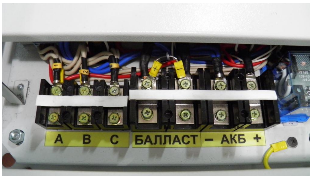
Рис. 3 Расположение силовых клеммников в клеммном отсеке
